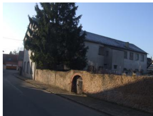
1973 ?N° 7 rue de la Heid Anc. Lamps
